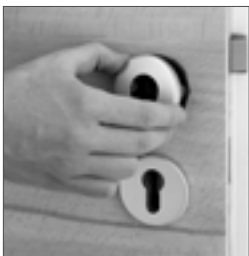
Einbau der Rosetten am Türblatt.
