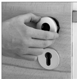
Einbau der Rosetten am Türblatt.
