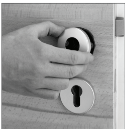
Einbau der Rosetten am Türblatt.
